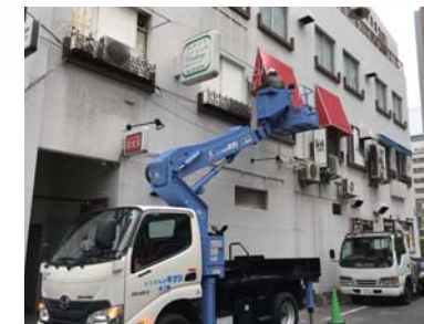
高所作業(テント生地貼り換え)
